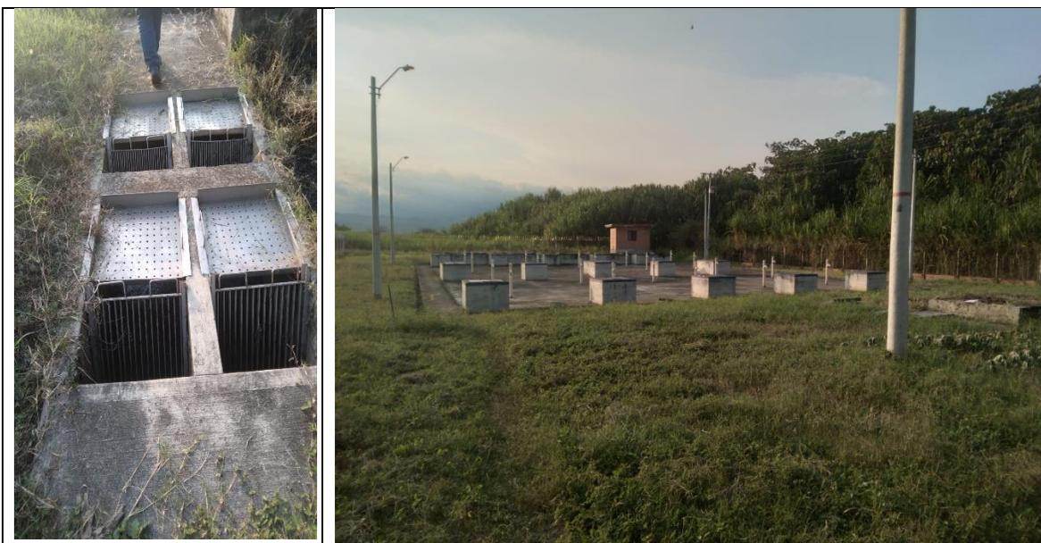
En el momento de realizar la visita se encontró vigilancia en la PTAR. Se puede observar en las dos fotografías, la primera en la margen izquierda indica el canal de entrada por un desbaste fino, posteriormente el agua debe ingresar al proceso de depuración, donde la PTAR se subdivide en 5 reactores que Aparentemente deben tener flujo interno longitudinal y paralelo.
